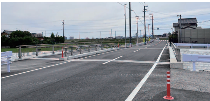
計画的に更新された橋りょう
