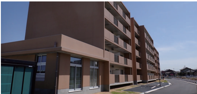
住みよい環境を目指した市営住宅（市営井杭山住宅）
