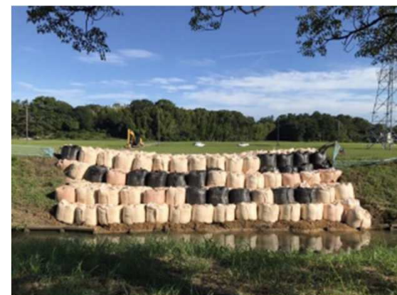
半場川 堤防 応急復旧工事の状況
