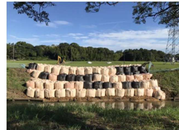
半場川 堤防 応急復旧工事の状況
