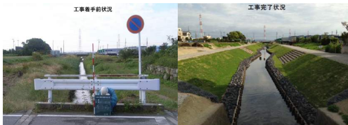
写真：多自然川づくり整備工事（着手前・着後）
