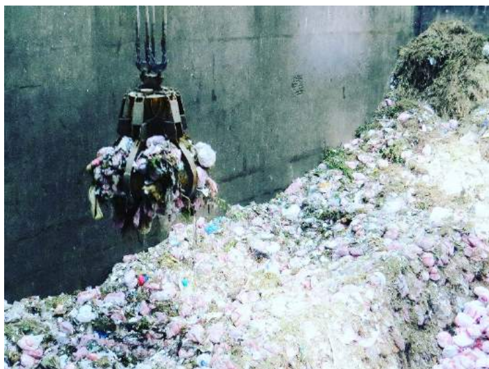
写真：ごみピットの様子（環境クリーンセンター）
