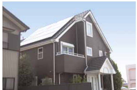
住宅用太陽光発電システム
