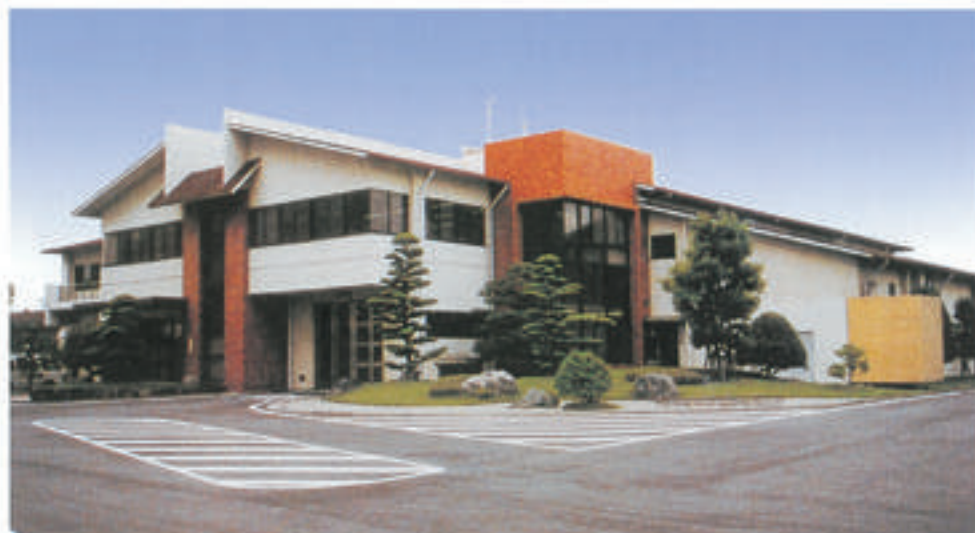
▲安城市かんきょうクリーンセンターしにようしょ理せつ
